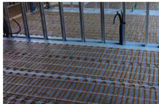
Installation du système de chauffage Warmset dans la province de Vicence, associée à une chape autonivelante.
