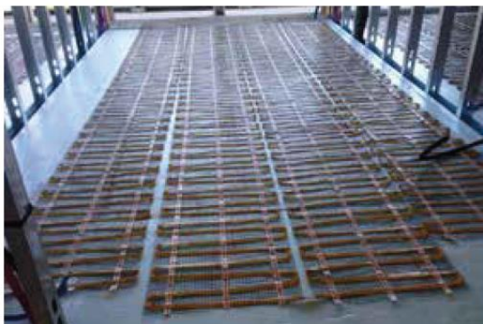
Installation du système de chauffage Warmset dans la province de Vicence, associée à une chape autonivelante.
